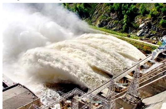
Рис. 1. Впечатляющая и завораживающая наше воображение энергетическая мощь речной воды, сбрасываемой через открытые водоводы в железобетонной плотине с искусственно созданного водохранилища современной ГЭС [2]
