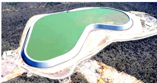
Рис. 10. Потрясающий общий вид с высоты «птичьего полета» огромного железобетонного водохранилища на вершине удаленного от городов горного массива современной гидроаккумулирующей электростанции «Таум Саук» (США) [13]
