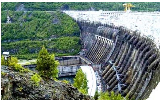
Рис. 9. Общий вид крупнейшей в России Саяно-Шушенской ГЭС плотинного типа мощностью 6400 МВт (р. Енисей) [4]
