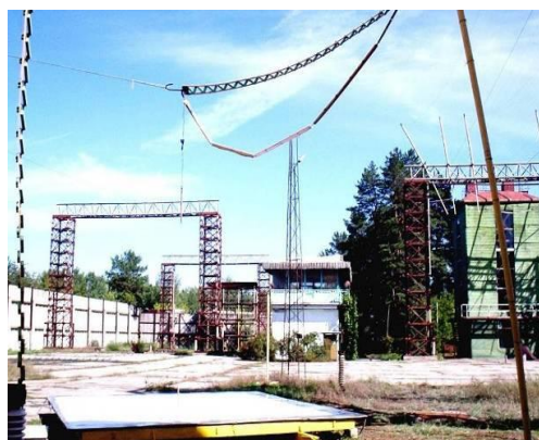
Рис. 7. Общий вид делителя ОДН-2 на номинальное напряжение 2,5 МВ, подсоединенного в разрядной цепи ГКИН к двухэлектродной системе "игла-плоскость"
