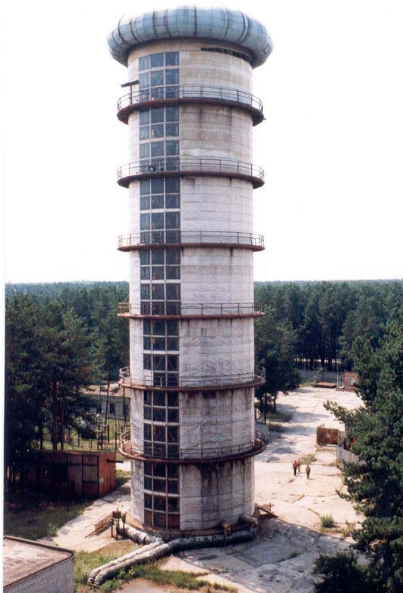
Рис. 4. Общий вид ГИН наружной установки на номинальное напряжение 14 МВ с запасаемой энергией в 2,24 МДж
