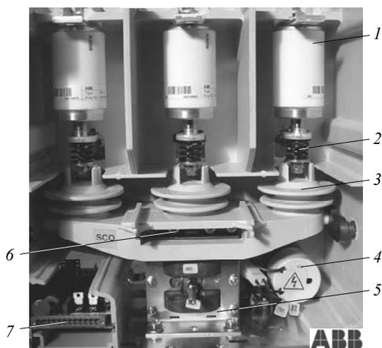
Рис. 6. Вакуумный контактор серии VSC 7 (7,2 кВ) производства АВВ
