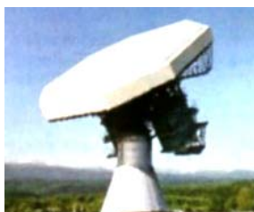
Рис. 11. Внешний вид уникального радиооптического комплекса распознавания космических объектов (РФ), оснащенного рядом грозозащитных панелей типа ПГЗН-Р для защиты от прямых ударов в его элементы молнии [18, 37]
