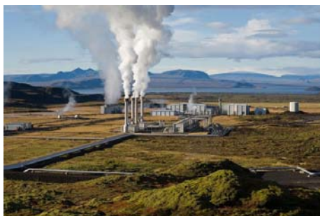
Рис. 21. Внешний вид современной ГТЭС с установленной мощностью 100 МВт (2001 г., Несьявеллир, Исландия) [22]
