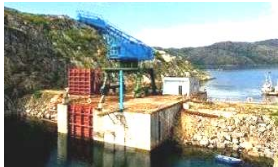
Рис. 26. Общий вид ПЭС «Кислогубская» мощностью 1,7 МВт (1968 г., Кислая губа, Кольский полуостров, РФ) [6]
