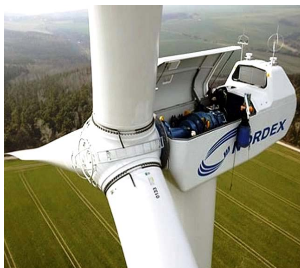
Рис. 4. Укрупненный вид турбины современной горизонтально-осевой трехлопастной ВЭУ марки NORDEX установленной мощностью до 1500 кВт сухопутного базирования в период ее техобслуживания на высоте около 70 м [11]
