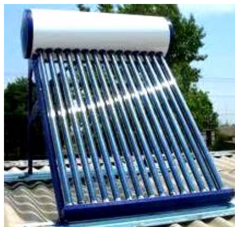
Рис. 10. Общий вид солнечного коллектора при фототермическом способе использования энергии светового потока [3]
