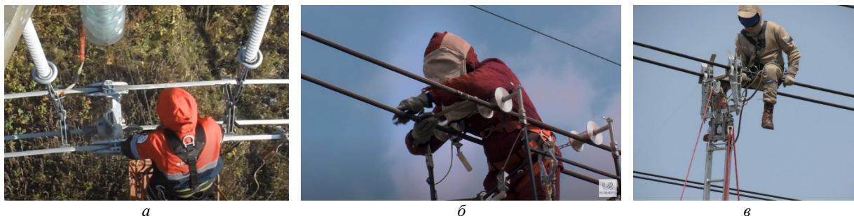
Рис. 1. Типове положення тіла працівника при виконанні робіт на потенціалі ЛЕП, де в якості опори він використовує проводи, що знаходяться під навантаженням
