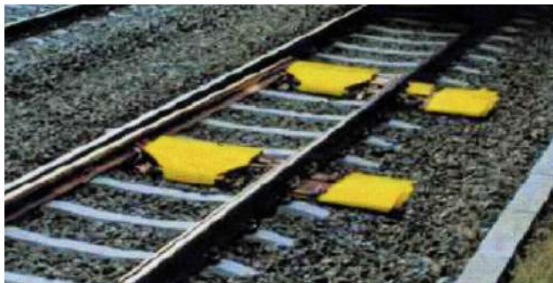
Рис. 1. Загальний вигляд стрілочного переводу EBI Switch 2000
