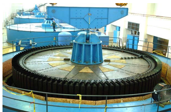
Рис. 8. Общий вид машинного зала мощной ГЭС в момент подъема ротора одного из ее крупногабаритных электрогенераторов вертикального исполнения [4]
