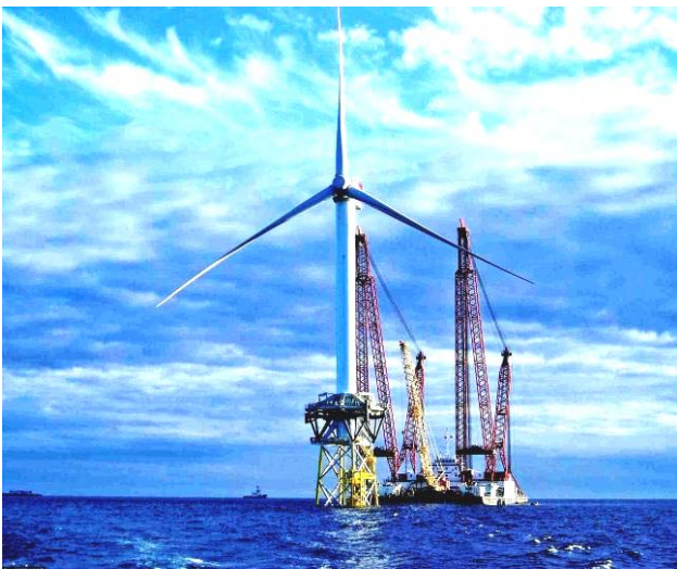
Рис. 7. Момент подготовки к монтажным работам на современной горизонтально-осевой трехлопастной ВЭУ установленной мощностью до 600 кВт морского базирования [11]
