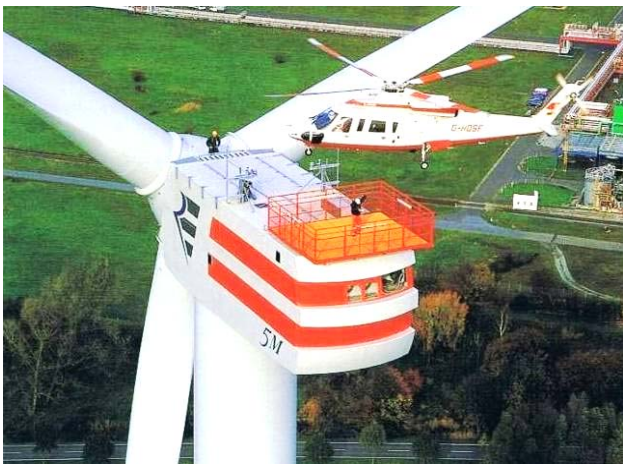
Рис. 6. Момент проведения с участием экипажа вертолета техобслуживания на высоте 80 м норвежской горизонтально-осевой трехлопастной крупнейшей ВЭУ с установленной мощностью до 5000 кВт сухопутного базирования [11]
