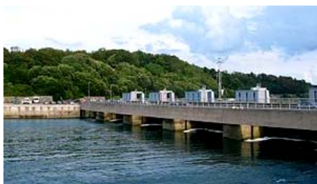
Рис. 25. Общий вид ПЭС «Ля Ранс» мощностью 240 МВт (1967 г., река Ранс, Северная Бретань, Франция) [6]
