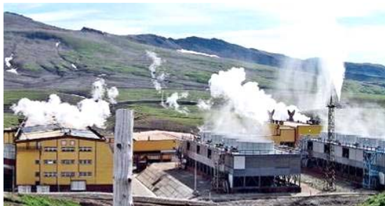
Рис. 22. Внешний вид Мутновской ГТЭС с установленной проектной мощностью 50 МВт (2002 г., Камчатка, РФ) [22]
