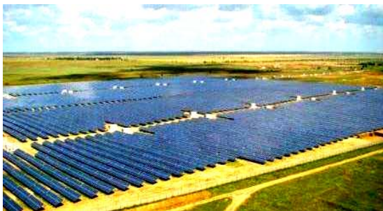
Рис. 15. Общий вид фрагмента территории СЭС «Охотниково» с установленной мощностью 80 МВт (Крым) [18]
