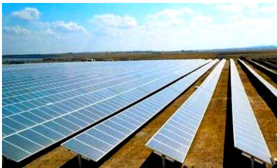
Рис. 16. Общий вид фрагмента территории СЭС «Перово» с установленной мощностью 100 МВт (Крым) [18]
