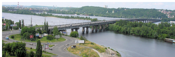
Рис. 10. Общий вид Киевского цельносварного моста через реку Днепр ("моста Патона"), построенного в 1953 году [17]
