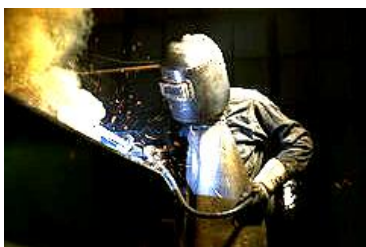
Рис. 18. Газовая сварка при помощи факела, образуемого сгоранием ацетилена в среде кислорода (фото 1942 года) [3]
