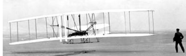
Рис. 34. Самолет "Флайер-1" братьев Райт с бензиновым ДВС, совершивший в 1903 году свой первый полет [14]
